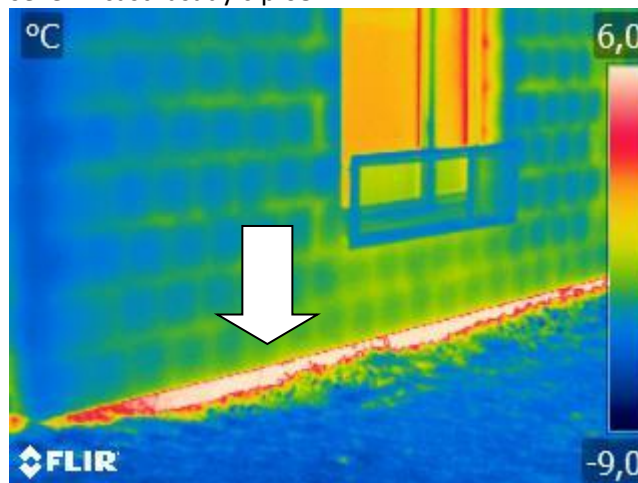
severní část fasády č.p.687
